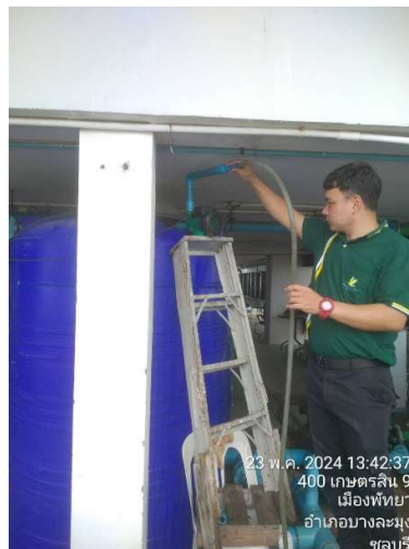
ภาพที่ 16 แสดงการล้างถังเก็บถังน้ำสำรองคาคฟ้า
