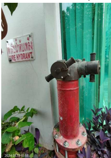
ภาพที่ 42 แสดงหัวรับน้ำดับเพลิงจากภายนอกอาคาร
