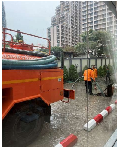
ภาพที่ 7 แสดงการสูบล้างจากบ่อบำบัดน้ำเสีย
