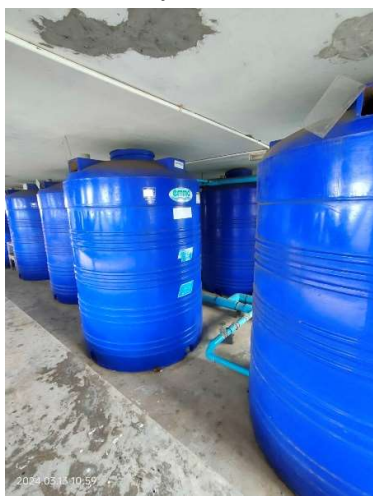
ภาพที่ 10 แสดงถังเก็บน้ำสำรองคาดฟ้า
