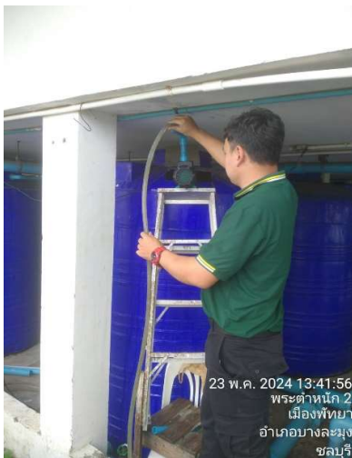
ภาพที่ 15 แสดงการล้างถังเก็บถังน้ำสำรองคาคฟ้า
