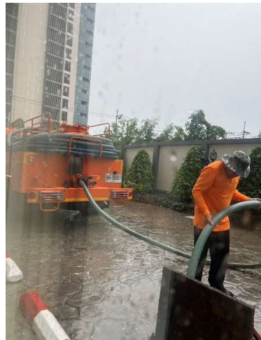
ภาพที่ 8 แสดงการสูบล้างจากบ่อบำบัดน้ำเสีย
